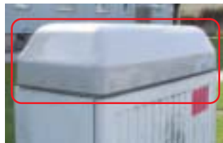
Aufgerüstet: Die W-LAN-Hardware sitzt auf den TV-Verteilerkästen.
