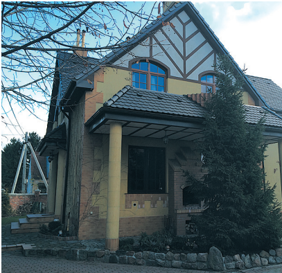
Обособняк в Центральном районе. 2010 г., 200 кв.м, 2 уровня, дизайнерский ремонт, мебель, 3 спальни, гостиная с камином, гараж на 3 авто на участке, 8 соток в собственности
