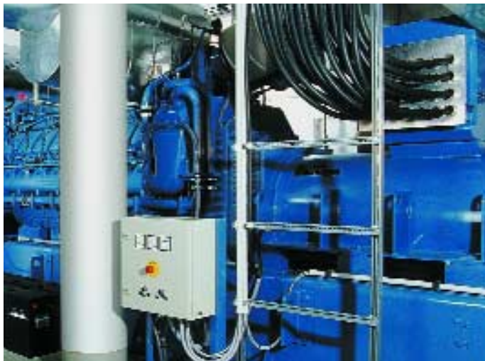
DIESEL: Wenn der Strom ausfällt, versorgen gewaltige Schiffsmotoren die Server mit Energie.
