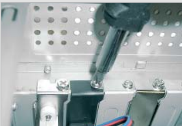
4 Dopo aver effettuato le connessioni elettriche, il regolatore del regime di rotazione della ventola può essere posizionato in uno degli slot posteriori
