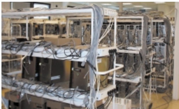
Pro technika ráj – zdánlivě chaotická změť kabelů v záhořovně.
